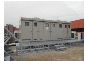
対策後(屋上階)
