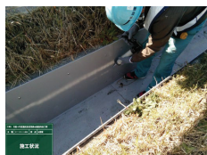
内面ライニング施工状況
