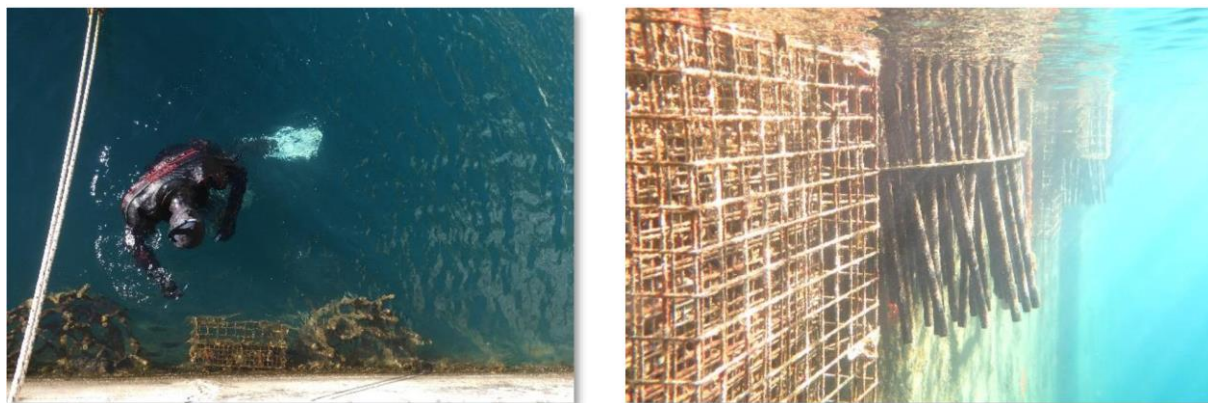
Figure 53: Photographies de biohuts installées dans le port de Fontvieille à Monaco (Crédits : Ecocean).
