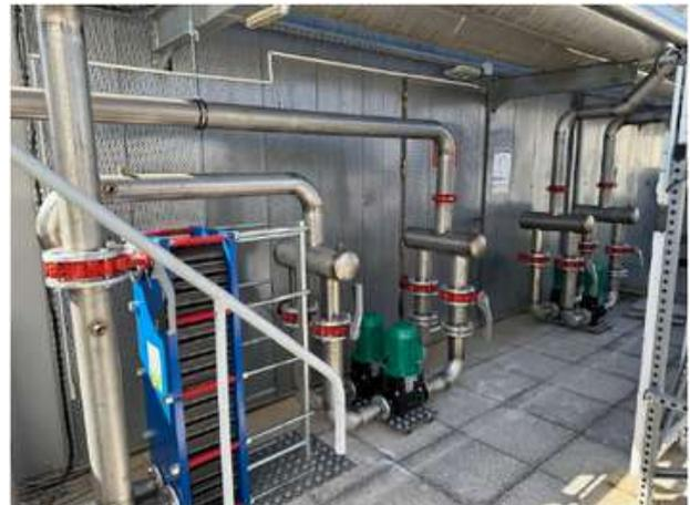
**Installation du calculateur pour ISDM-MESO incluant la création d'un circuit de refroidissement par tour adiabatique, le renforcement d'un plancher et la redistribution électrique**
