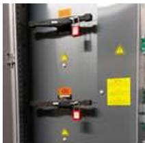
Consignation des onduleurs avec passage en bypass pour assurer le maintien de la production informatique, une procédure essentielle garantissant la sécurité du personnel intervenant sur le système électrique.
