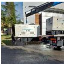
Mise en place des groupes électrogènes de secours pour une transition fluide lors de pannes de courant ou d'opérations de maintenance.
