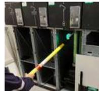
Vérification de l'absence de tensions sur l'arrivée haute tension.
