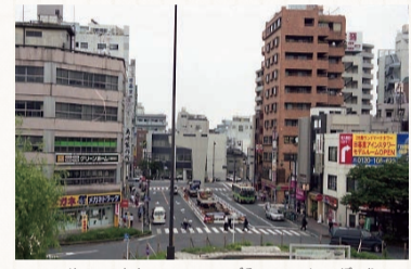
平成16年(2004)頃には日暮里・舎人ライナーの鉄橋の工事が行われていました
