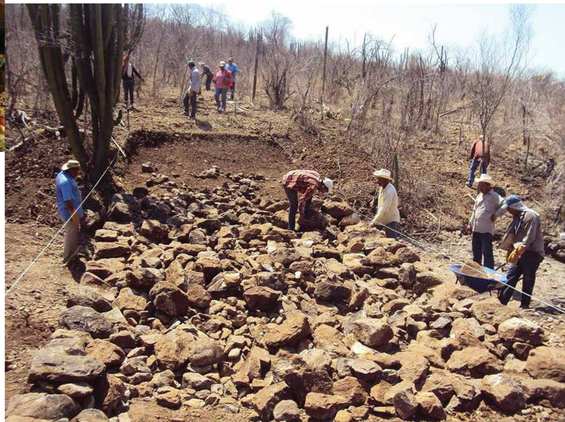
Presa de piedra acomodada en La Labor de Santa Lucía, Sonora, Área de Protección de Flora y Fauna Sierra de Álamos Río Cuchujaqui. Foto: Archivo CONANP.
