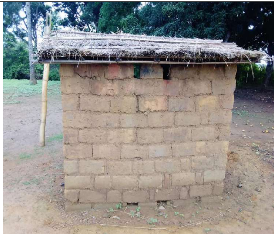
Latrine hygiénique à Kiandu province du Kongo central
