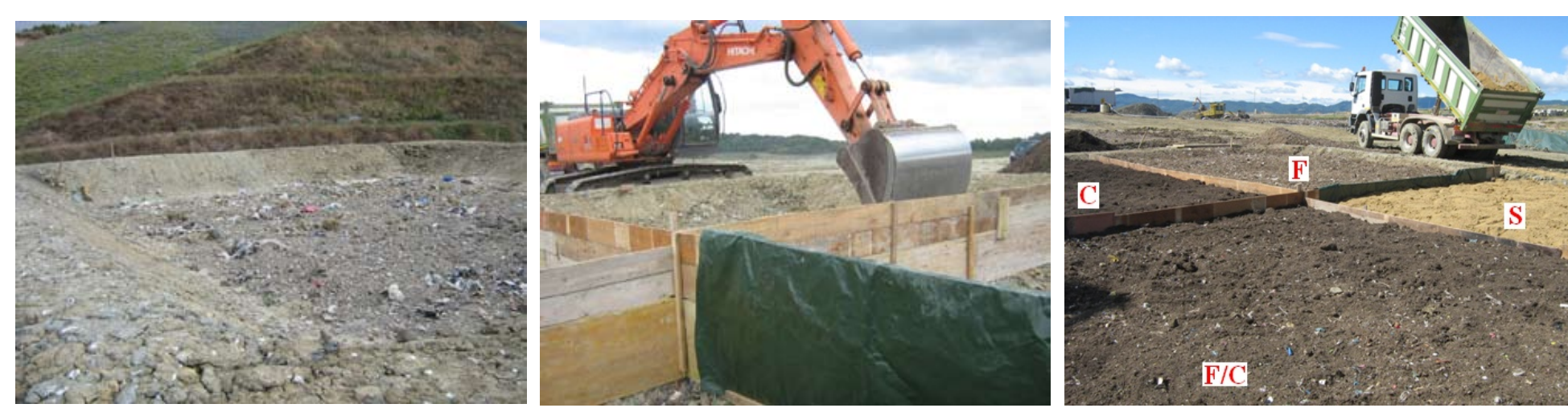
Figura 3. Fasi di costruzione dell'impianto pilota
