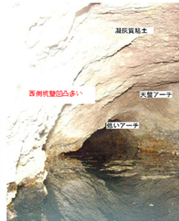
図1 0°方向の坑壁と北側の空洞
