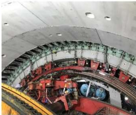
写真1 坑内状況写真(マシン上部)
