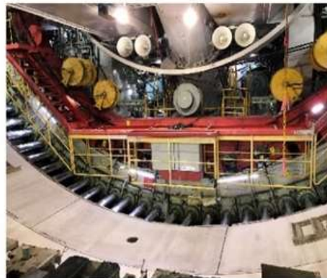
写真2 坑内状況写真(マシン下部)
