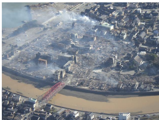
写真 令和6年能登半島地震に伴い石川県輪島市で発生した大規模市街地火災の焼失範囲（三重県防災航空隊撮影）
