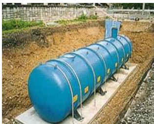
【耐震性貯水槽】
