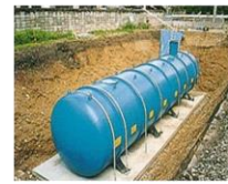
【耐震性貯水槽】
