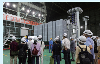
変圧器が落雷によって壊れることがないか製品の信頼性を試験する工程を紹介(千葉工場)
