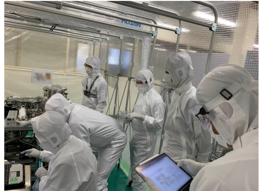
クリーンブースを設営完了し、試運転中
