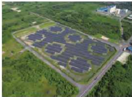
下松メガソーラー発電所
