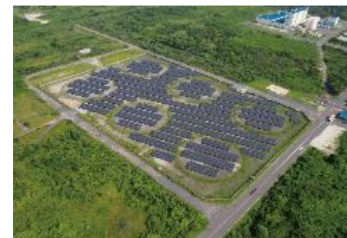
下松メガソーラー発電所
