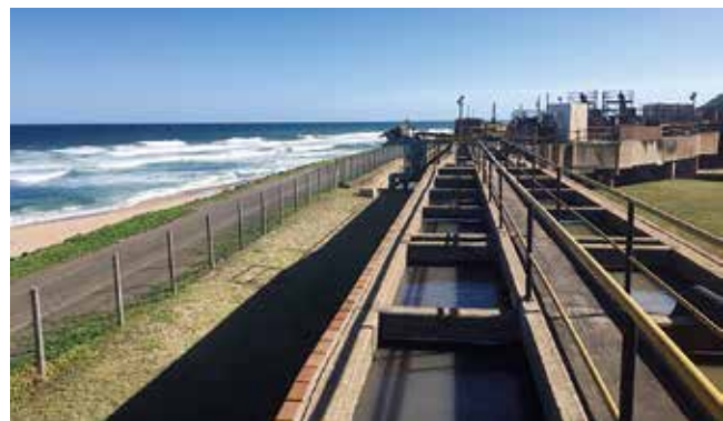
「RemixWater」の実証事業を行う計画となっているダーバン市の既設下水処理場
