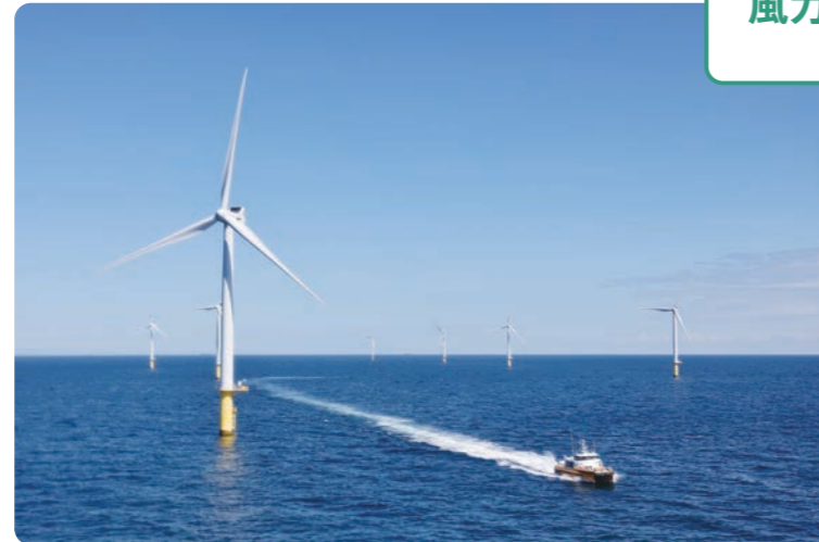
ルフトダウネン洋上風力発電所
