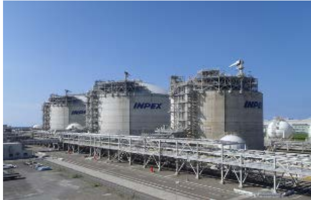
直江津LNG基地
