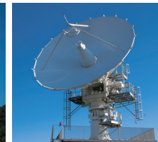
勝浦第3受信局用パラボラアンテナ 直径11m
