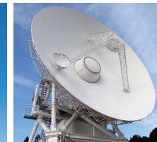
勝浦第3受信局用パラボラアンテナ 直径11m
