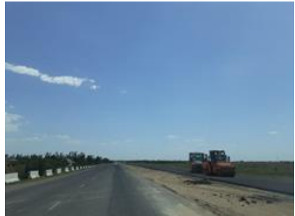
A378 (イエッティトム〜グザル間、右車線は道路建設工事中)
