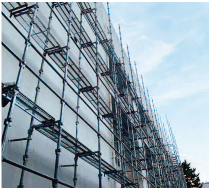
現場を通りかかった業者から「足場の組み方がきれいだったので発注したい」と依頼の連絡があったことも
