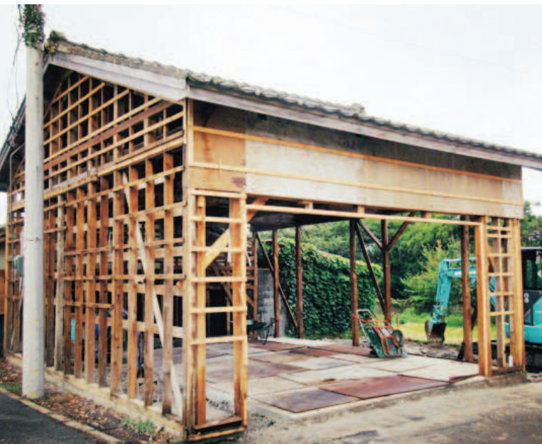
お母様が営んでいた縫製工場を解体。現在内装工事を行っている
