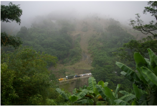
写真-3.16 信義橋付近の被害状況
