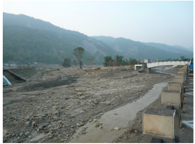
写真-3.33 甲仙橋上流側の被災状況
