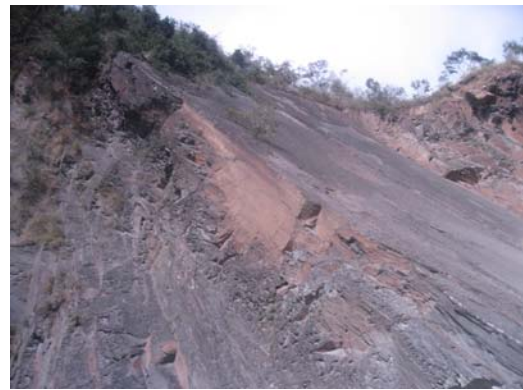
写真 2-9 右岸側の頁岩 (slate) の状況
