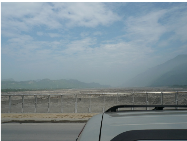
写真-3.17 新威橋（上流側を撮影）
