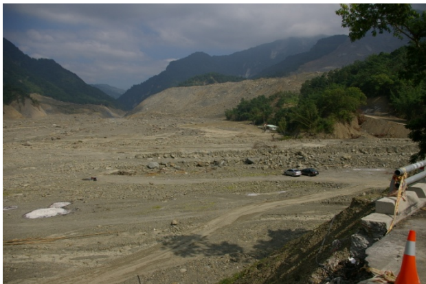
写真-3.36 小林村の被災状況（上流側を向いて撮影）
