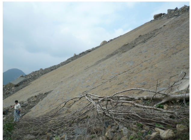
写真-3.42 千枚岩の流れ盤
