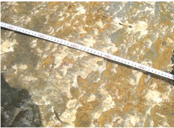
写真2-17 方解石表面の状況
