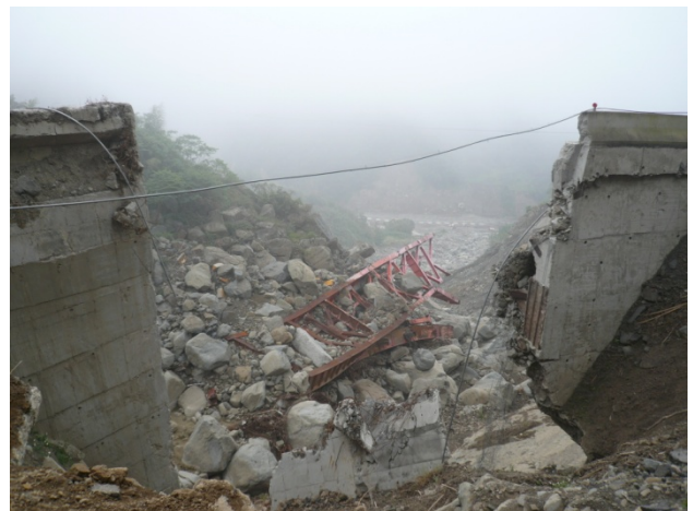
写真-3.15 鋼製トラスと控え壁式擁壁
