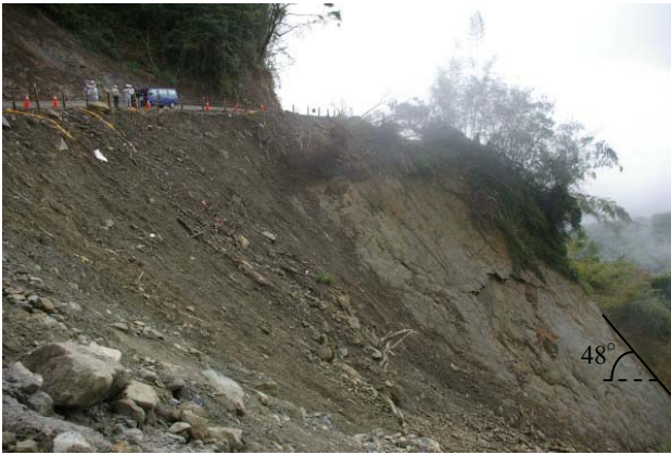
写真-3.5 道路下の滑り面
