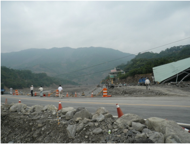
写真-3.31 寶来第二橋の上流側の様子
