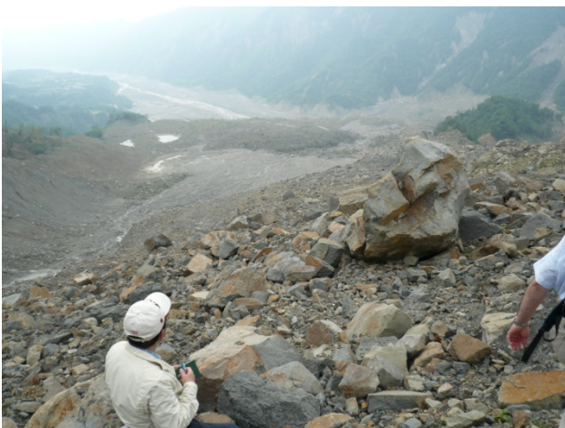
写真-3.40 左岸側斜面崩壊の上部からみた下流側の状況
