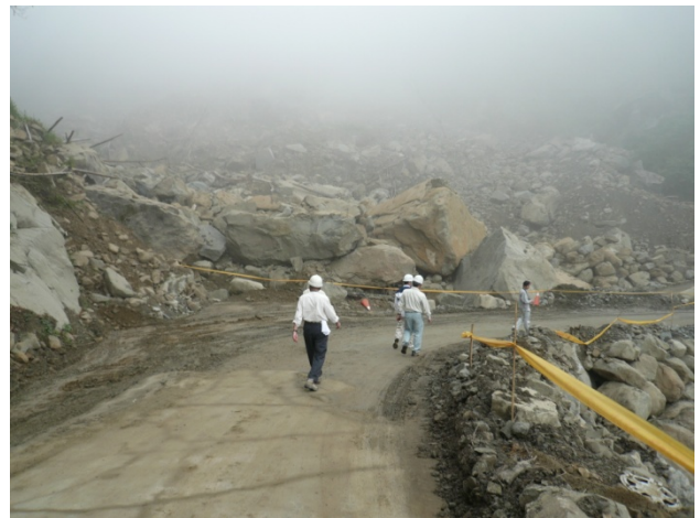
写真-3.13 斜面崩壊箇所の落石
