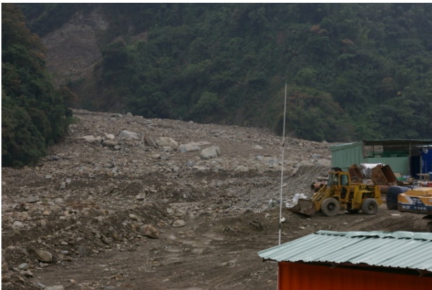
写真-3.12 土石流の堆積箇所
