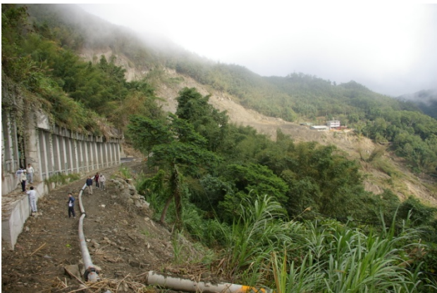
写真-3.1 龍頭坪の被害状況
