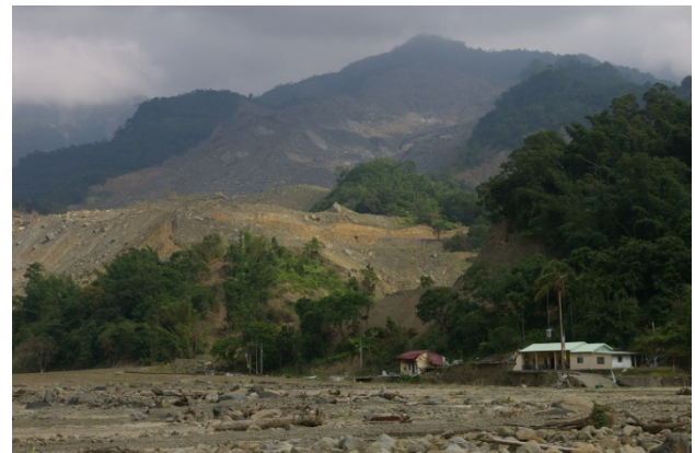
写真-3.37 左岸側の崩壊
