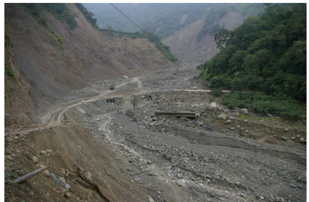
写真-3.30 緑茂地域の橋の上流の状況
