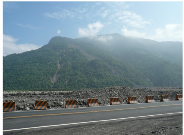
写真-3.19 五號隧道付近の右岸側
