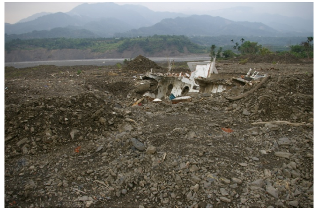
写真-3.23 新開村の被災状況
