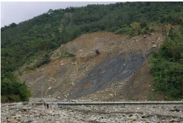
写真-3.7 巴沙娜橋上流側の斜面崩壊
