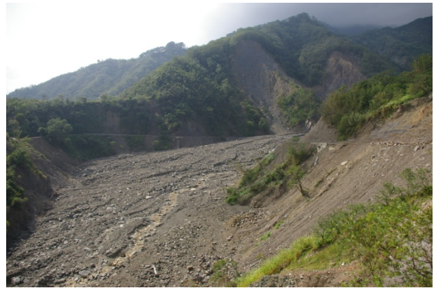
写真-3.24 桃源郷中心街の西側の被害状況
