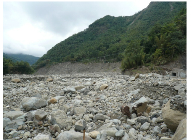
写真-3.9 巴沙娜橋の下流側の状況
