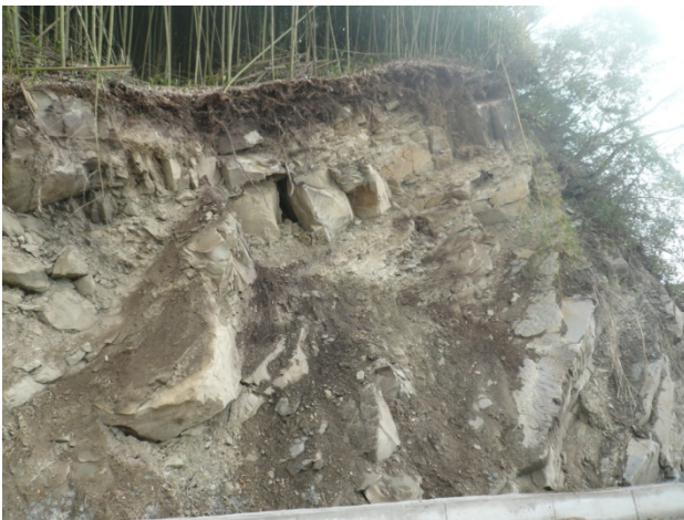
写真-3.6 頁岩のスレーキングが見られる箇所
