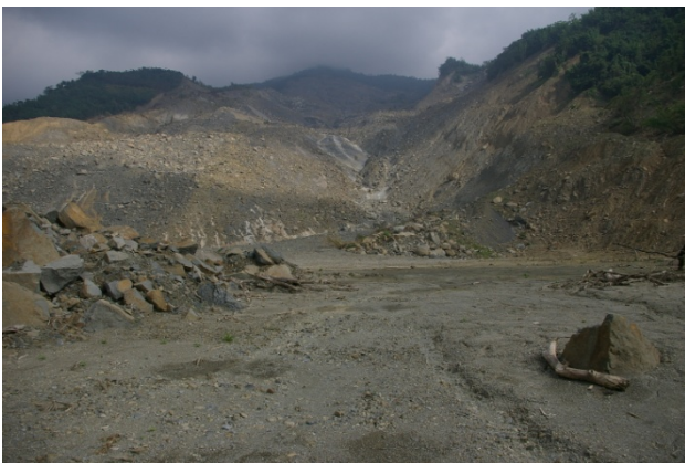
写真-3.39 左岸側斜面崩壊の中間地点
