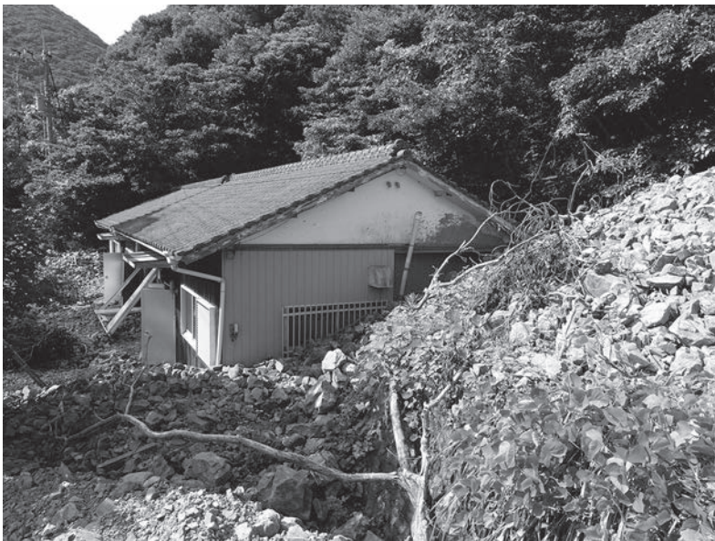
写真2 下流の家屋に到達した崩壊土砂(大月町橘浦)
