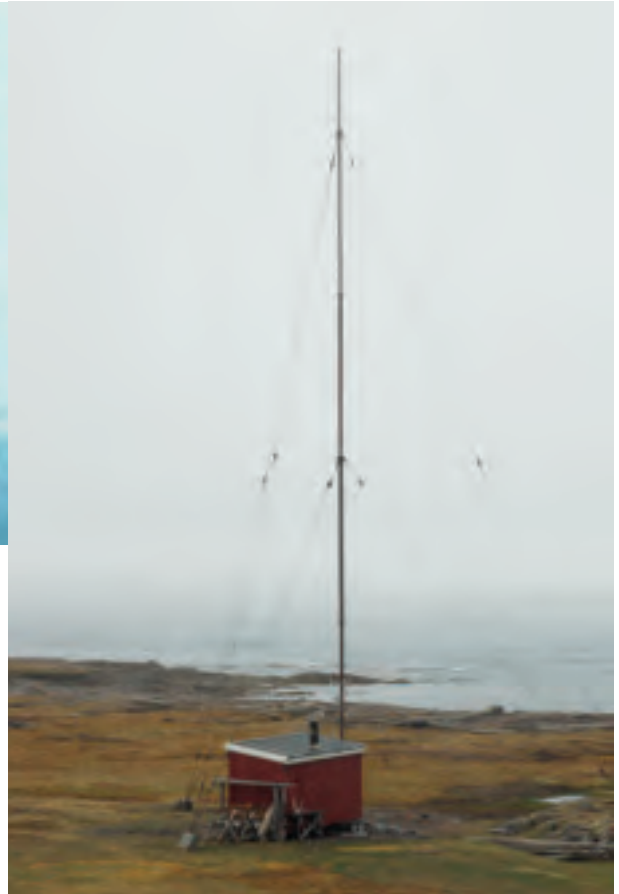
FUGLEHUKEN hytte og radiomast (2009) Foto: Kartverket
