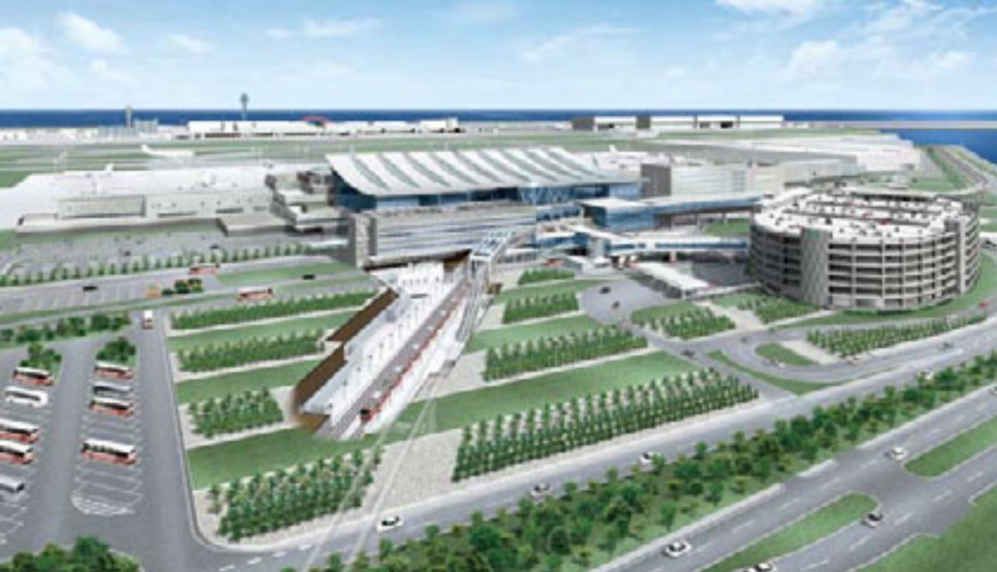
国際線旅客ターミナルビルと京急の「国際ターミナル」駅(仮称)。
