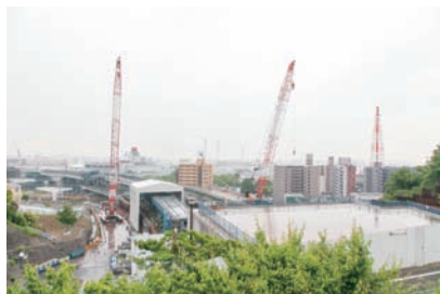
「子安台公園」からの眺め。手前は首都高の工事現場。
