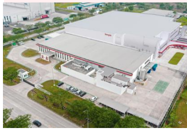
キユーピーインドネシア工場新棟
