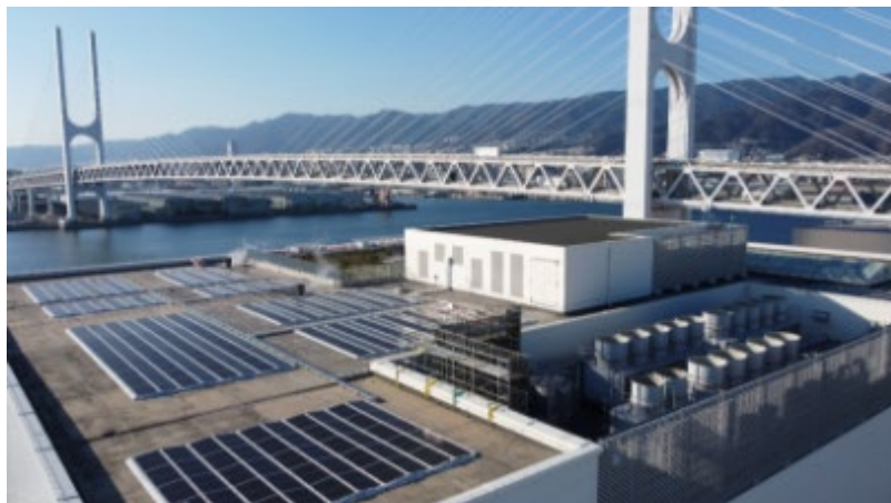
キューピー神戸工場屋上に設置した太陽光パネル
