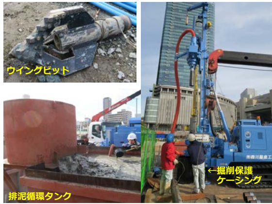
図5 開発したボーリングマシンと掘削状況
