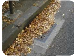
排水枡の上に落ち葉が堆積している
