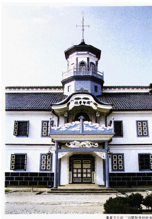
重要文化財「旧開智学校校舎」
