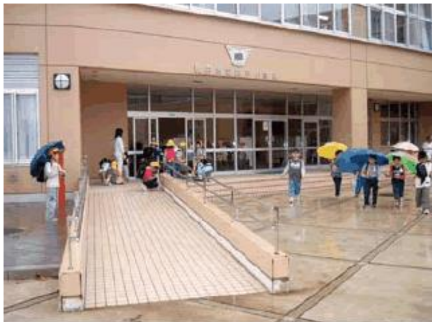
昇降口の段差を解消するため設置したスロープ (秋田県秋田市立勝平小学校, 「平成28年版障害者白書」より)
