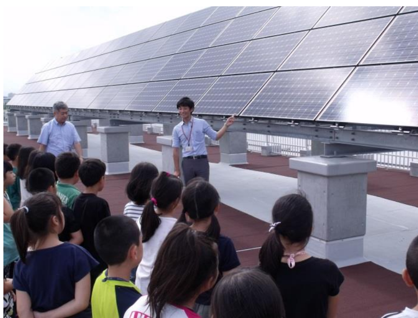
校舎屋上に設置された太陽光パネル(環境教育の教材として活用)
