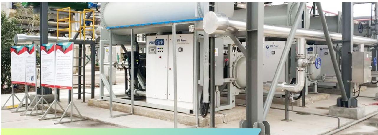
变换余热有机朗肯循环发电装置
