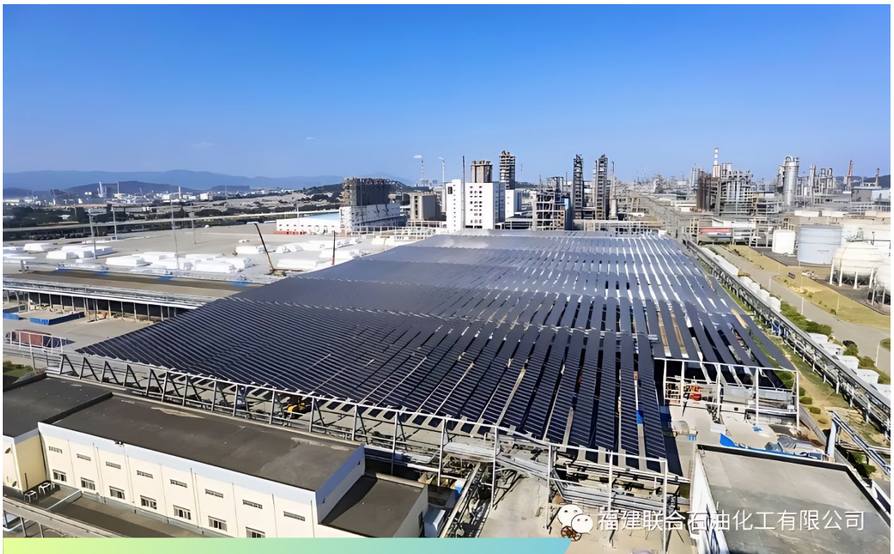
光伏发电系统
