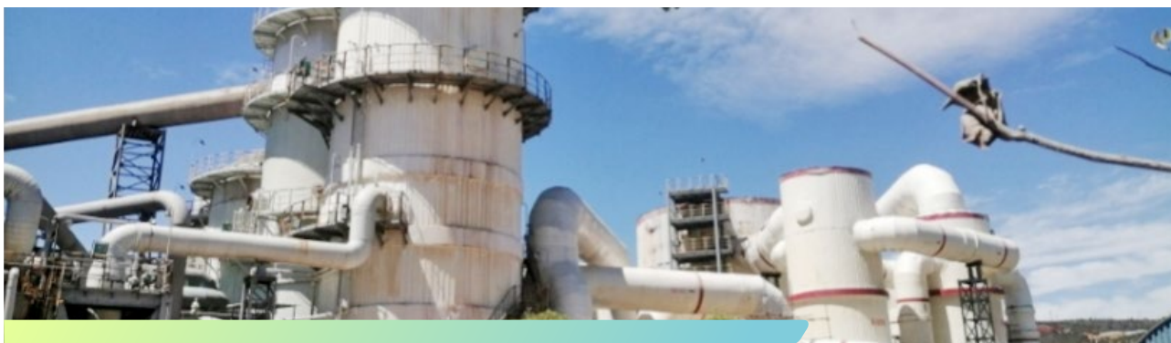
余热回收装置
