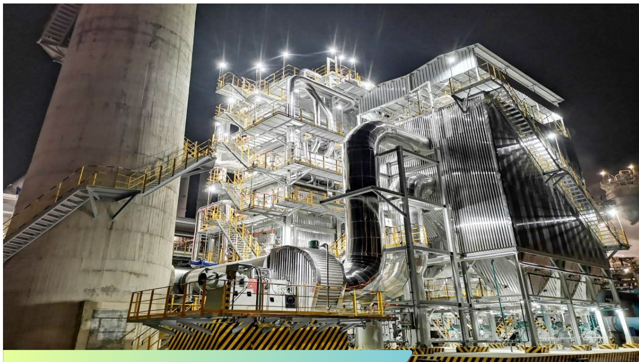
MTO 装置 \pi 型余热锅炉
