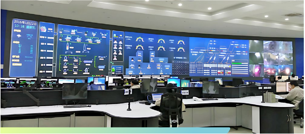
能源管控中心
