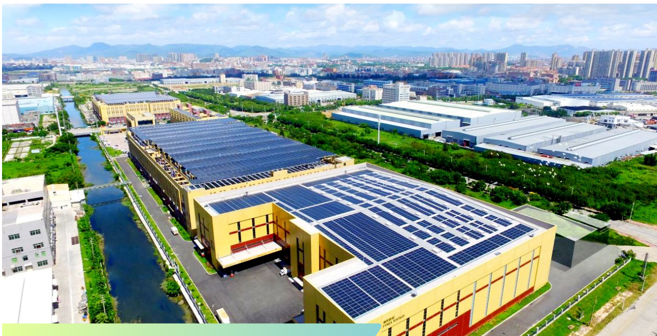
光伏发电系统
