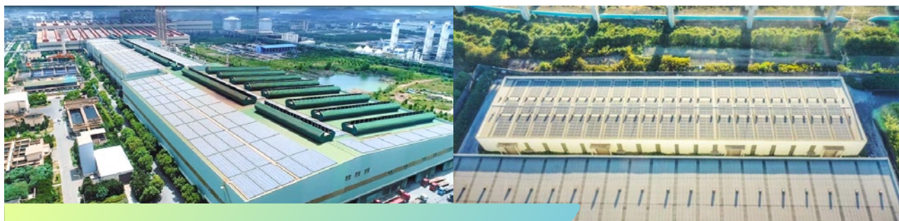
屋顶光伏发电系统
