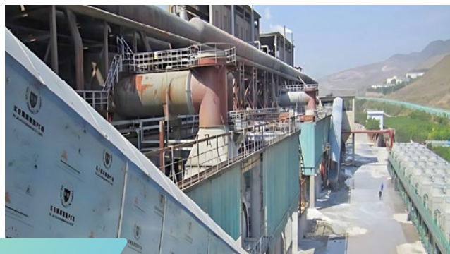
改造后：烟气全部收集，现场无可视水蒸气
