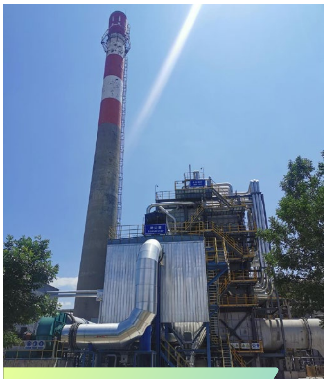
MTO 余热锅炉改造项目
