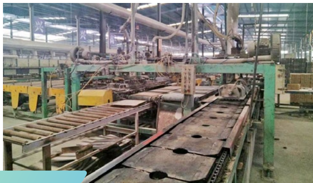
铺贴陶瓷外墙砖系统烟气管道
