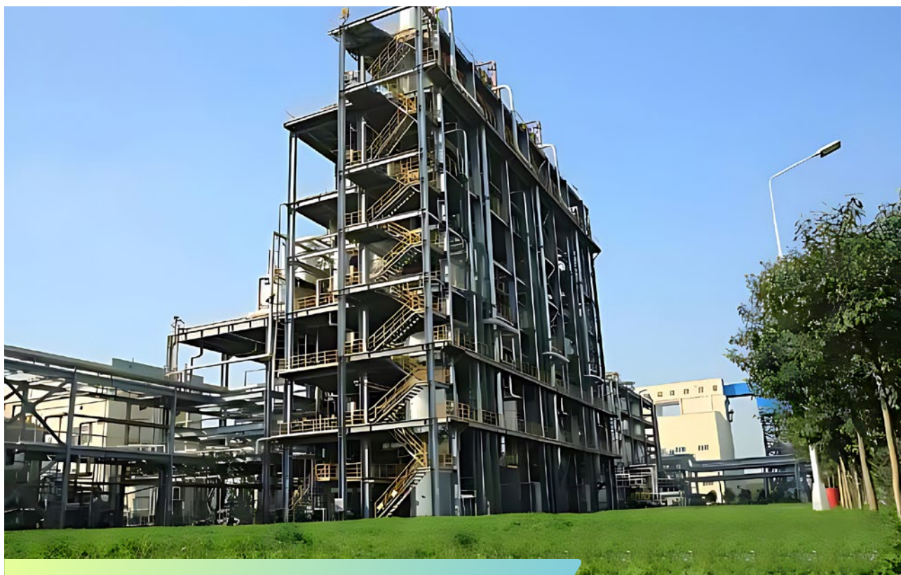
四喷嘴对置式水煤浆气化工工艺装置
