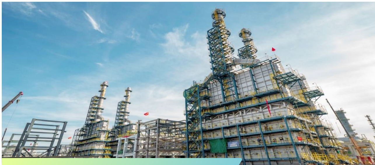
氯乙烯装置裂解炉
