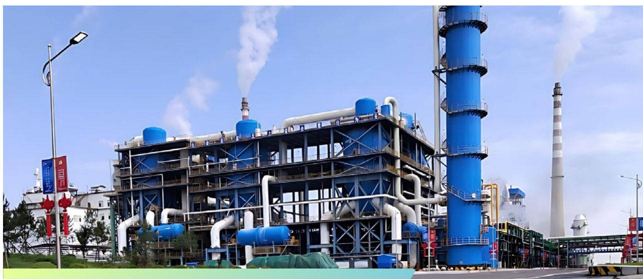
具有湿分解功能的多效真空蒸发结晶器
