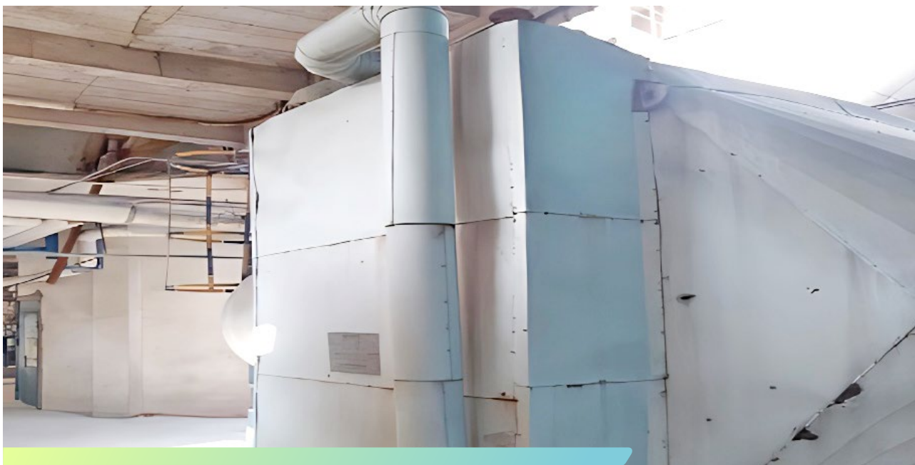
改造后的翅片换热器
