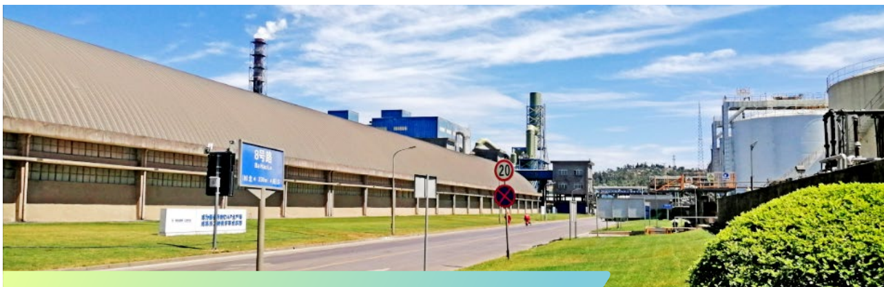
磷铵生产尾气治理改造后
