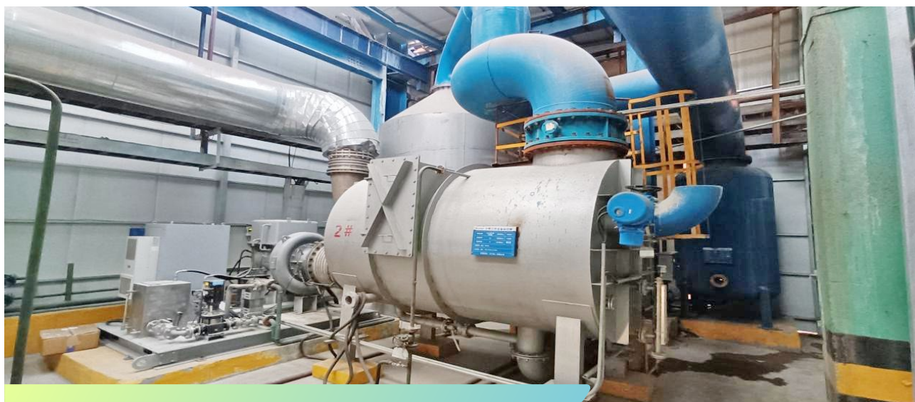
磁悬浮透平真空泵
