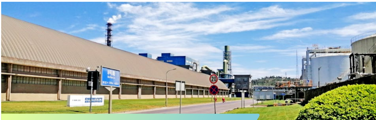
磷铵生产尾气治理改造后
