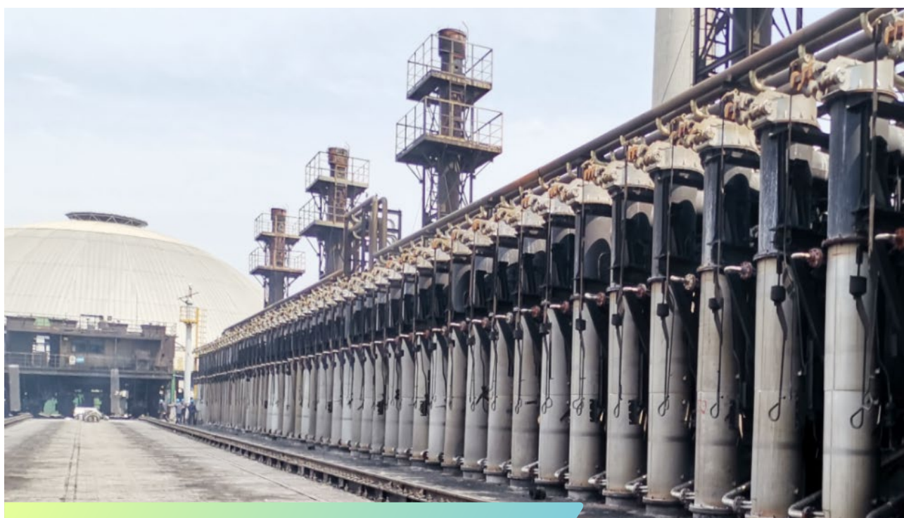
新型荒煤气换热器
