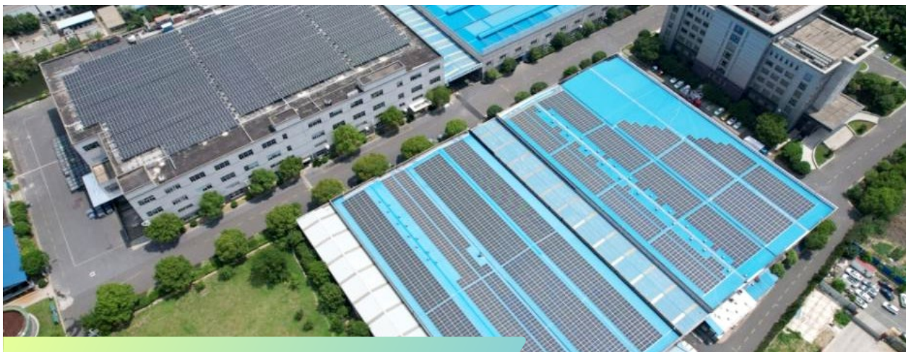
光伏发电系统
