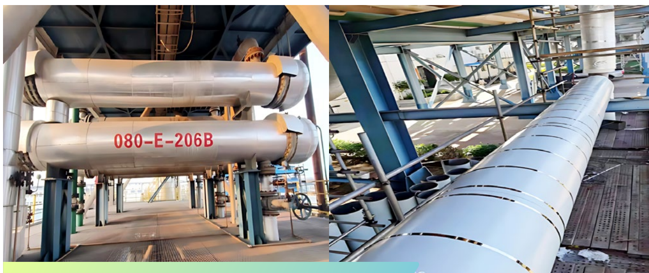
重整生成油与 S Zorb 装置精制汽油换热器和 3.5 兆帕蒸汽主管线气凝胶保温项目
