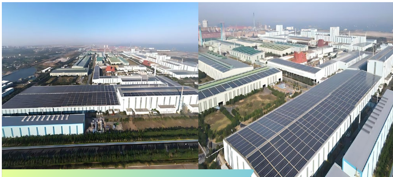
屋顶光伏发电项目
