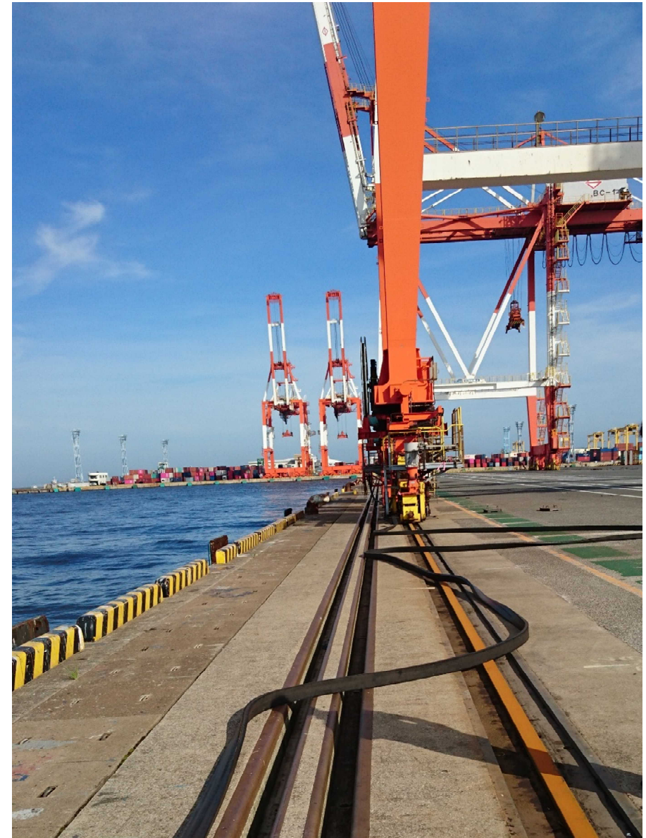
ガントリークレーン電源ケーブル逸脱
