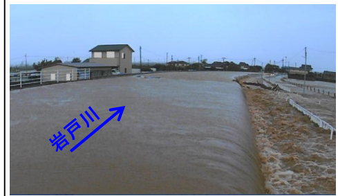
岩戸川の氾濫状況
