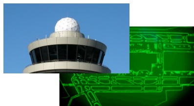
空港面監視レーダー(ASDE)
