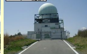
レーダー施設
