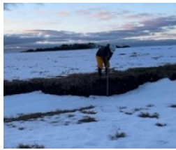
着陸帯の段差
