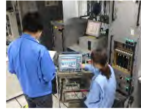
(航空保安施設点検実施状況)
