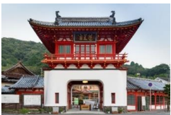
武雄温泉楼門
