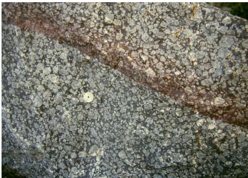
Figur 6 Sprekk (diagonalt fra øvre venstre hjørne) med tilhørende rødfarging (øvre høyre del av bildet).
