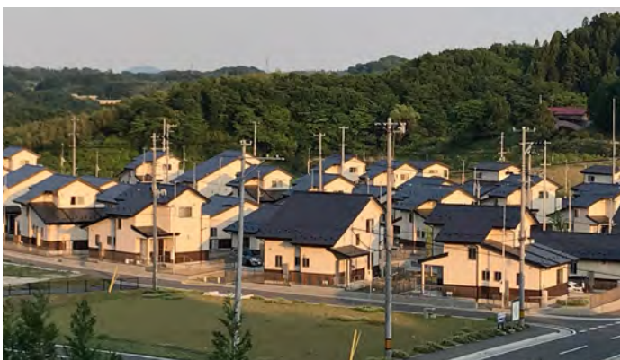
復興公営住宅は三春町恵下越地区と平沢地区に整備された
