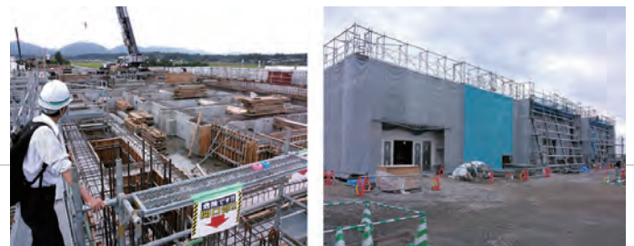
左：建設中の交流センター。右：建設中の地域エネルギーセンター(2018年8月27日撮影)
