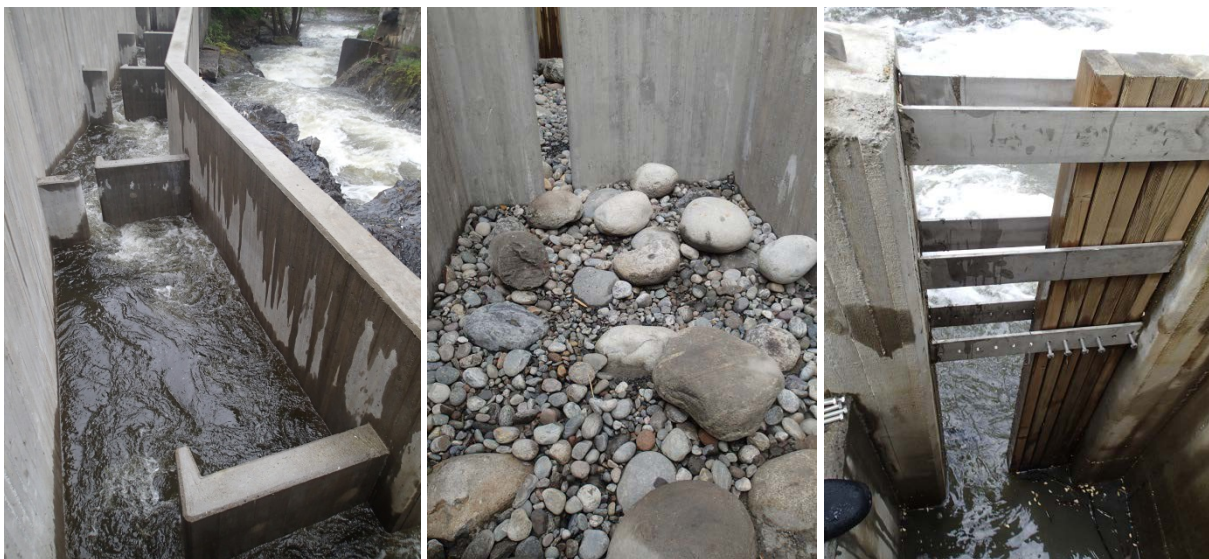
Figur 13 Norges første spaltetrapp i Akerselva Oslo med typisk diagonalt strømningsmønster, gjennomgående bunnsstrat og nålestengsel ved inntaket til finregulering av vannføring (Foto: Ulrich Pulg).
