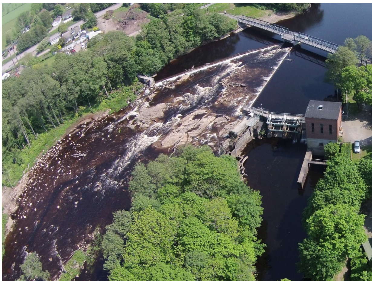
Figur 20 Naturtypisk omløp i Ätran ved kraftverk Herting (Foto: Fiskevårdsteknik AB, Sverige, med tillatelse)
