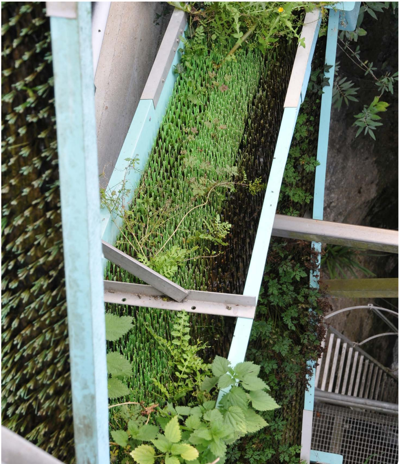
Figur 19 Ålpassasje ved kraftverk i Frankrike. Her ledes oppvandrende ål til en rampe fylt med «kunstgress» og vann. Denne og lignende metoder er benyttet på mange kraftverk i Frankrike, Tyskland, Irland og England. (Foto: Frode Kroglund).
