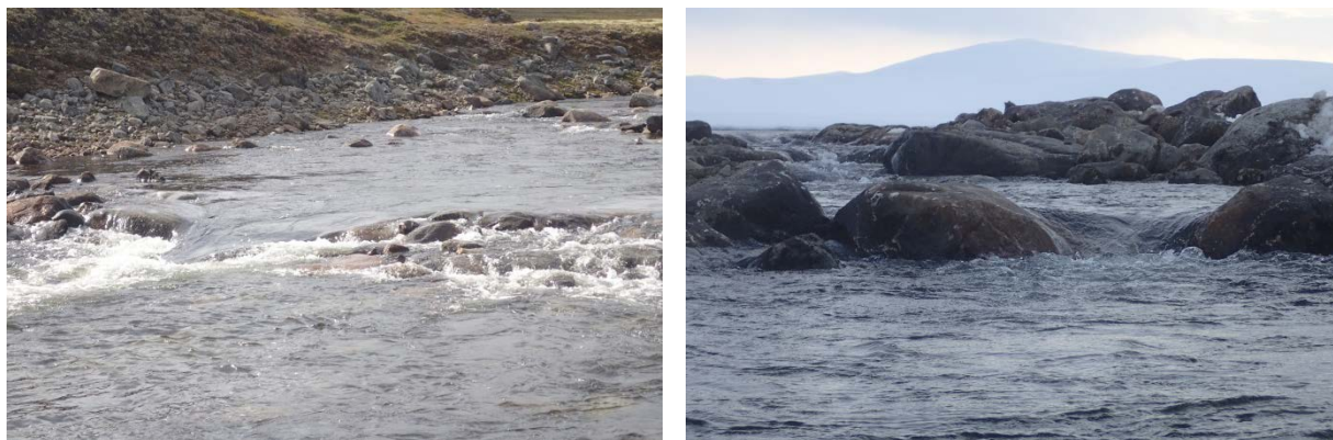
Figur 8 Detaljer fra lavvannsrennen i Djupa. Den er utformet som trinn-kulp-type med spalteformete overløp, til venstre ved en vannføring omkring medianvannføring, til høyre ved lavvannføring om vinteren. Vandringsmuligheter for fisk finnes ved alle forekommende vannføringer (Foto: Ulrich Pulg).
