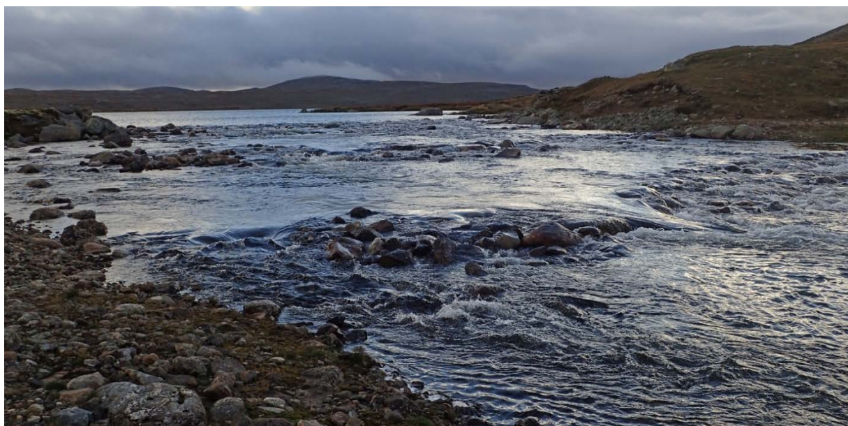
Figur 4 Djupa, utløp fra Langesjøen på Hardangervidda 2015. En geometrisk terskel fra 1960-tallet ble ombygget til en naturtypisk rampe med buner og lavvannsrenne. Høydeforskjellen er 2 meter (Foto: Ulrich Pulg).
