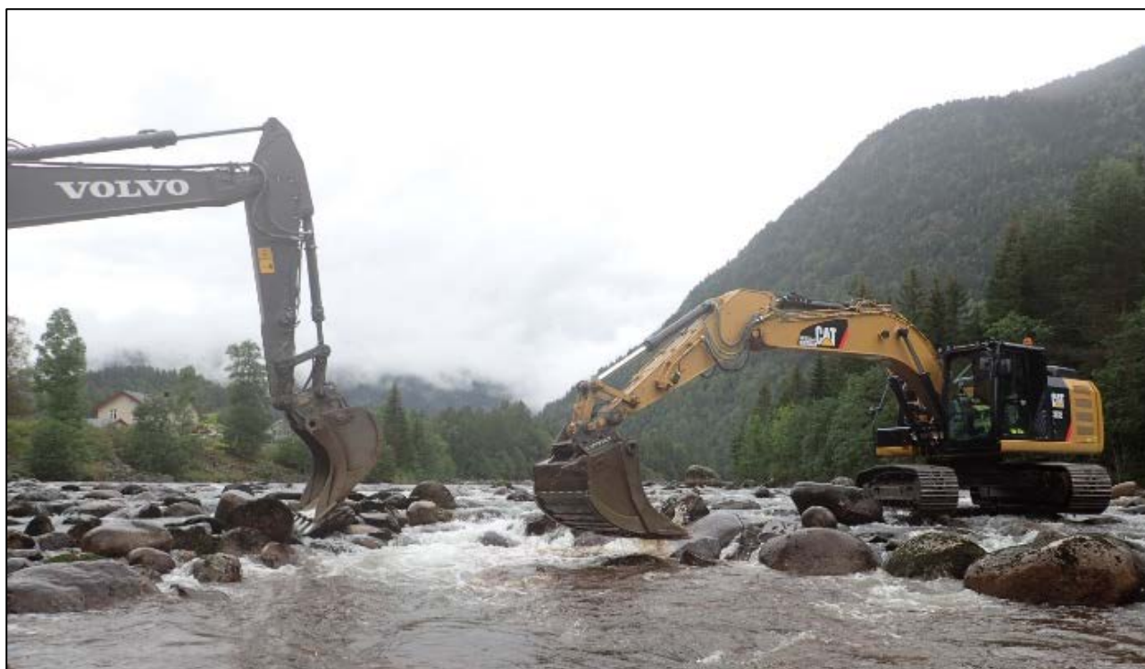
Figur 2 Fjerning av kunstige vandringsbarrierer kan gi full konnektivitet for fisk og bunndyr. Bildet viser fjerning av terskler i den kraftregulerte elva Tokkeåni (Foto: Ulrich Pulg).
