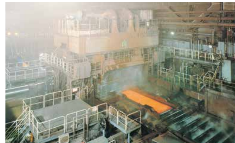
厚板仕上げ圧延機 Plate Mill
