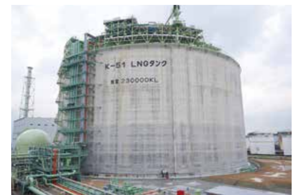
LNG貯蔵タンク(7%Ni鋼板を使用) LNG tank (7%Ni Steel)
