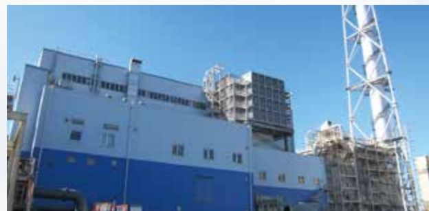
鹿島共同火力株式会社 KASHIMA KYODO ELECTRIC POWER CO., LTD.
