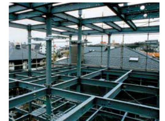
スマートビーム(溶接軽量H形鋼)の使用例(3階建住宅) An example of using Smart BEAM (Welded H-Shapes): (Three storied house)
