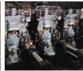
熱延仕上げ圧延機 Hot Strip Mill
