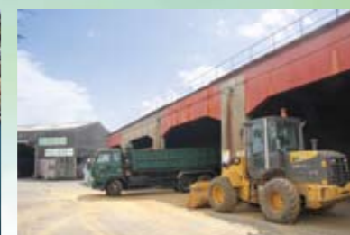
リサイクルセンター Industrial waste disposal plant
