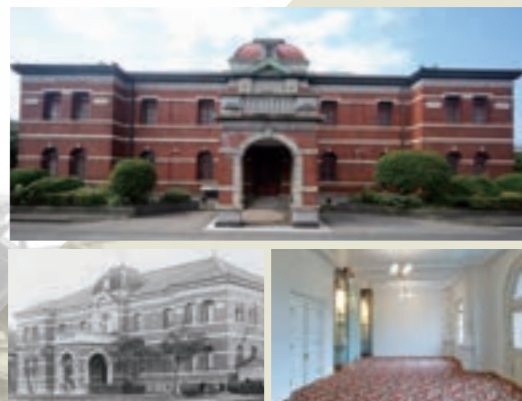
操業2年前の明治32年頃に竣工した日本事務所。 2年半の歳月をかけて2020年9月に内装整備工事完工(2F会議室)
