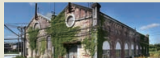
明治時代に建設された典型的な煉瓦建造物で、イギリス式煉瓦積み2棟の建物からなる遠賀川水源地ポンプ室。
