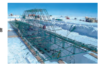
掘削場の屋根の架設作業(2023年1月)
