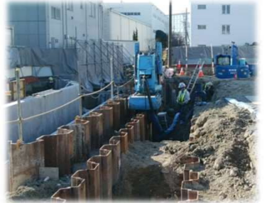
(鋼矢板設置工事イメージ)
