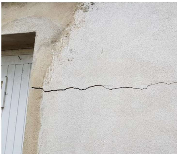
Fissure horizontale en façade située le long du Trieux
