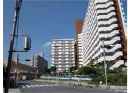
団地の商業施設（左奥建物）内に立地
