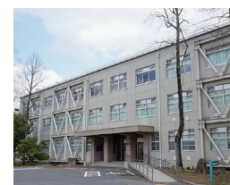
■総合理工学部2号館
