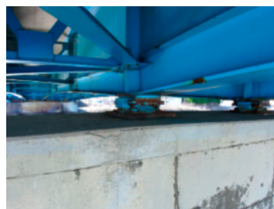
ドローンで撮影した橋脚と支承の様子
