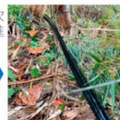
ケーブル網の応急復旧 (地面敷設)
