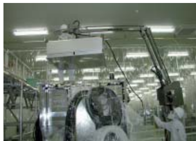
高所作業台およびバルンサー
